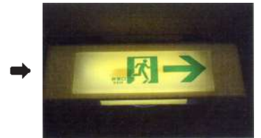
7年経過し劣化したパネル
