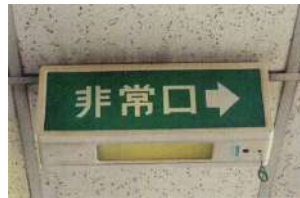
正常なパネル
