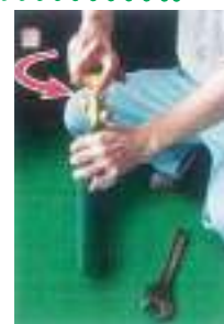
容器弁の点検
